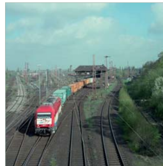
Rangierbahnhof Bremen-West Drehscheibe für den Güterverkehr auf der Schiene
